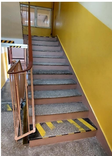
Zdjęcie nr 2 – schody wewnętrzne
