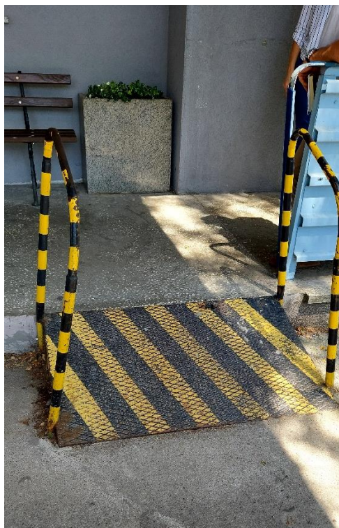
Zdjęcie nr 3 – wejście z podjazdu
