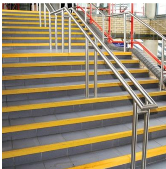
Rys 4 przykład oznaczenia schodów i zastosowania środkowej poręczy
